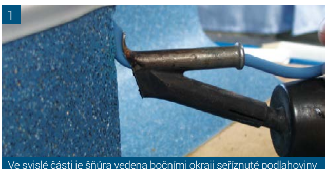
1 Ve svislé části je šňůra vedena bočními okraji seříznuté podlahoviny
