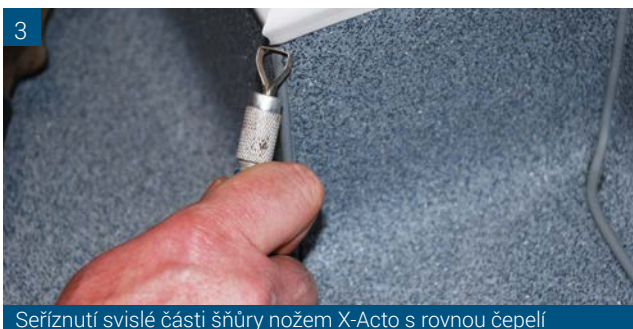
3 Seřiznutí svislé části šňůry nožem X-Acto s rovnou čepelí
