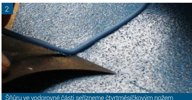
2 Šňůru ve vodorovné části seřizneme čtvrtměsíčkovým nožem
