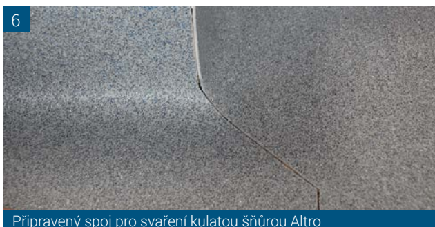
6 Připravený spoj pro svaření kulatou šňůrou Altro
