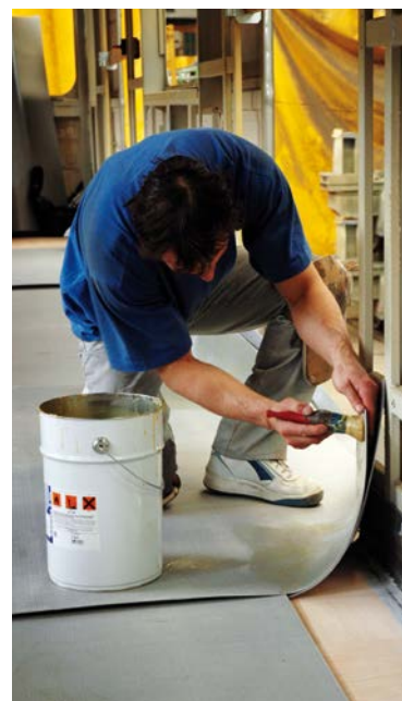
Aplikace kontaktního lepidla
