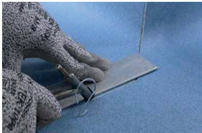
2. Ve vodorovné části podlahy drážku vyfrézujte ručním drážkovačem.
