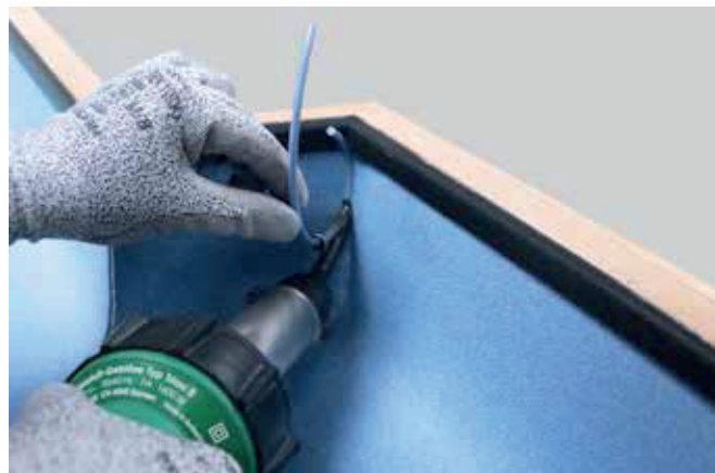
2. Protáhněte svařovací šňůru tryskou a začněte svařovat spojsměrem od shoradolů.
