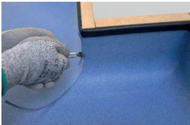
5. Svislou část svařovací šňůry seřezávejte obdélníkovou čepelí X-Acto. Čepel pravidelně dobrušujte!
