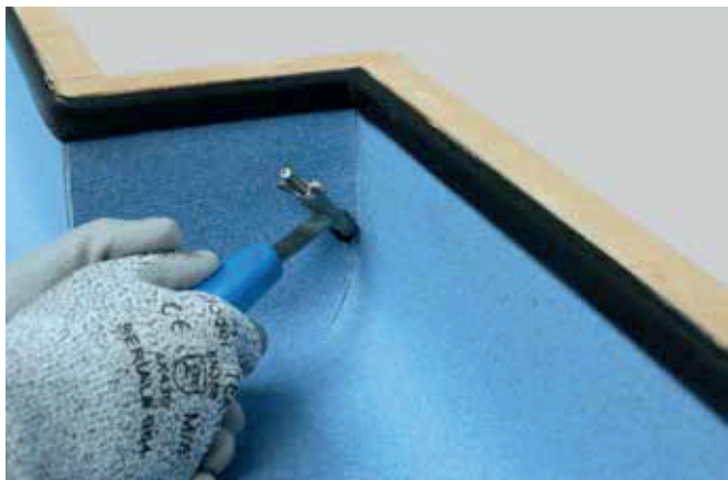
1. Vyfrézujte drážku jak v celé délce koutového spoje.
