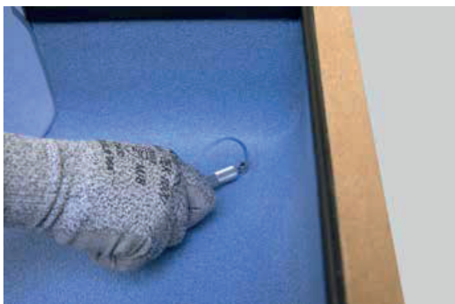
3. Po vychladnutí začistěte svár pomocí kulaté čepele X-Acto. Čepel pravidelně dobrušujte!
