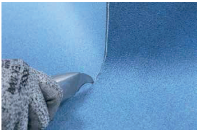
1. Pomocí nože se zahnutým břitem připravte část vnějšího koutu vytvořením „V“ drážky, která slouží jako příprava pro tepelné svařování.
