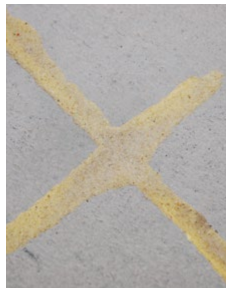
✓ Správné provedení sanace trhlin
