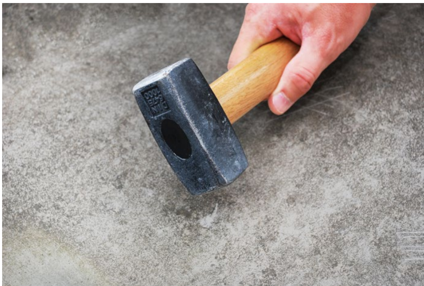
Správně provedená zkouška kladivem
